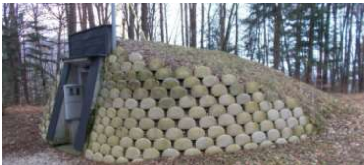
Slika: Obstoječi vodohran Drtija (DGD, Hidroinženinig d.o.o., maj 2023)
